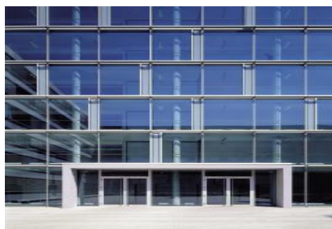
Slika 4. Prikaz objekta izvedenog od Low-E-STAKLA i Solar Control Glass tipa SGG ANTELIO od istog proizvođača [12]
